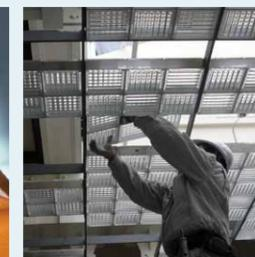
旧桜宮公会堂(P11)の施工写真。フレームの二辺をネジで枠に止めるだけの手軽な小型パネルです。
