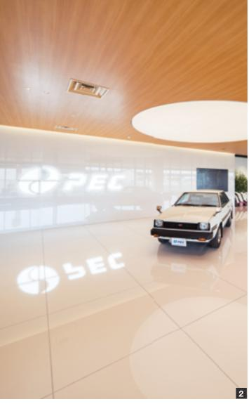
■新社屋のエントランスホール。企業の顔となるサインウォールやモニター が設置され、オートヒューズを初搭載した車両などが展示されている。 2壁面は1,200×3,000mm、床面は1,200×1,200mmの大判のデクトンを採用。 鏡面かつ大判仕上げが可能な「ハロ」が空間に広がりと変化を与えている。
