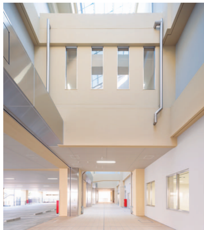
建物名称/東京都立光明学園 所在地/東京都世田谷区 設計/松田平田設計 施工/馬淵建設 撮影/大丸剛史
