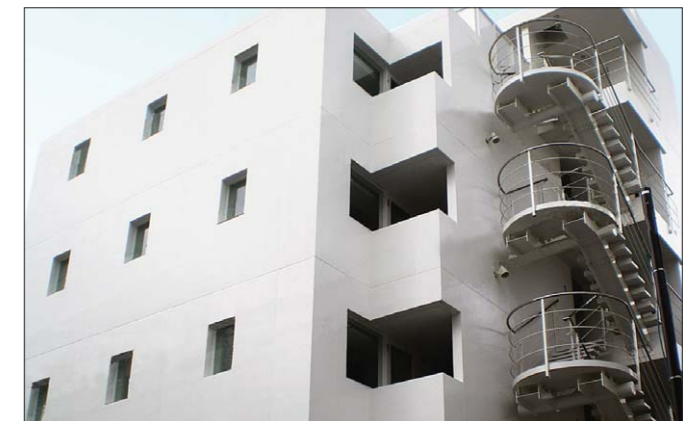
市ヶ谷薬王寺ビル (RC下地)
