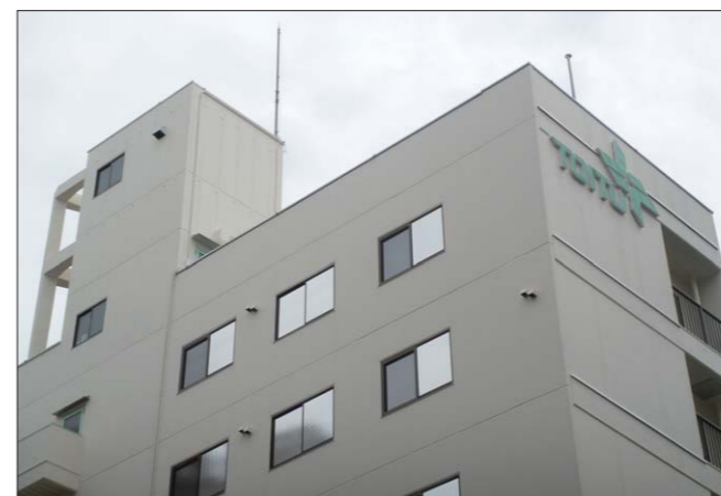
渋谷区恵比寿 T社屋外壁改修(光触媒コート仕様)
