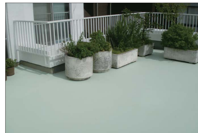
港区南麻布 O邸ルーフバルコニー改修(光触媒仕様なし)
