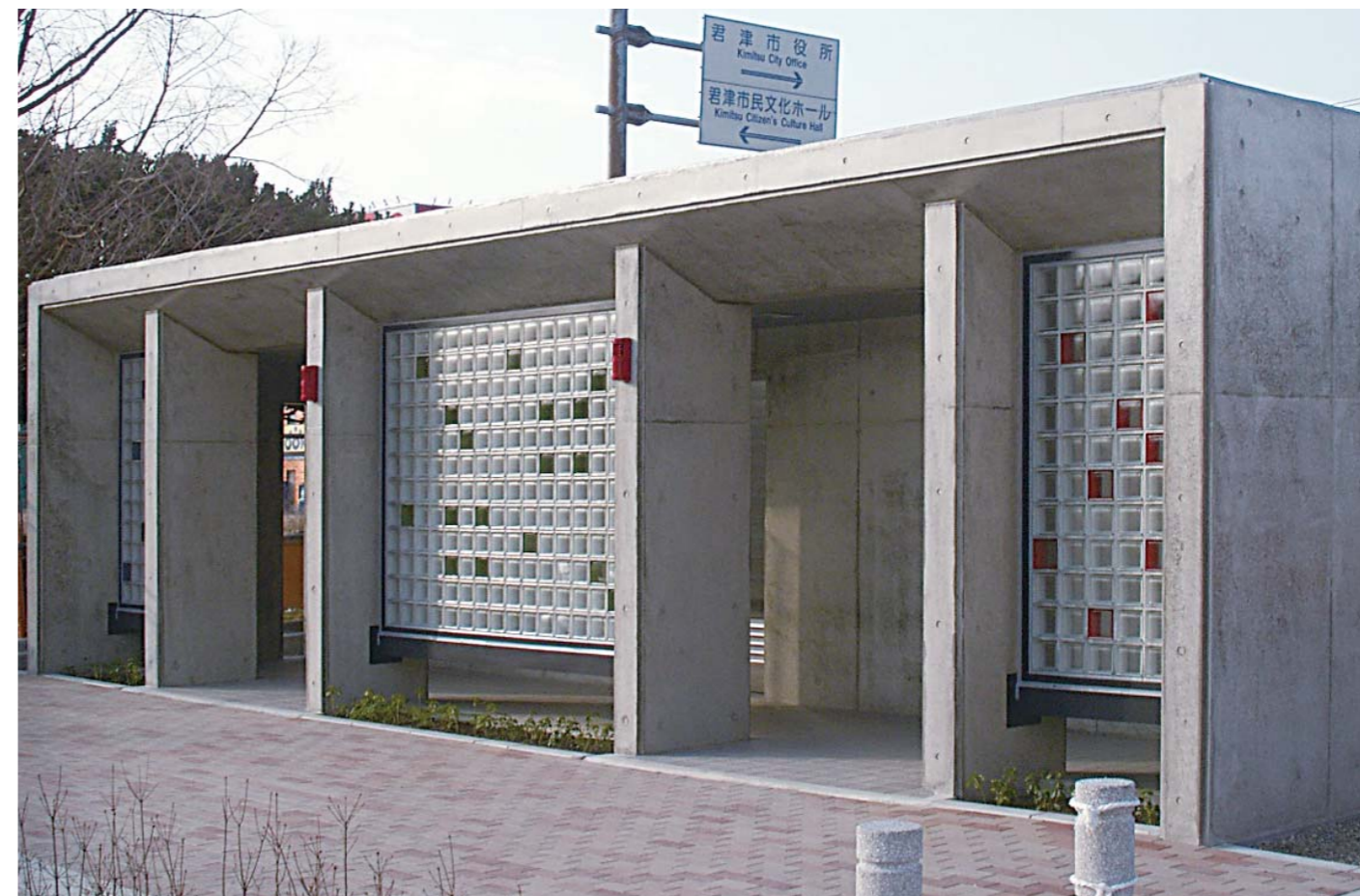
君津市内みのわ運動公園公衆トイレ（コンクリート・ガラスブロック・モザイクタイル面にSG落書きコートを塗布）
