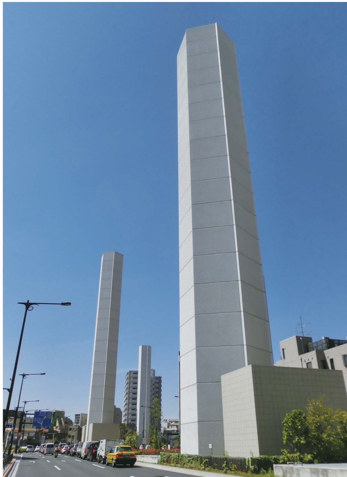
首都高速中央環状新宿線トンネル神山町換気所 (排気塔: PC板面にSGコート色付きを塗布 給気塔: タイル面にSGコート外装用を塗布)
