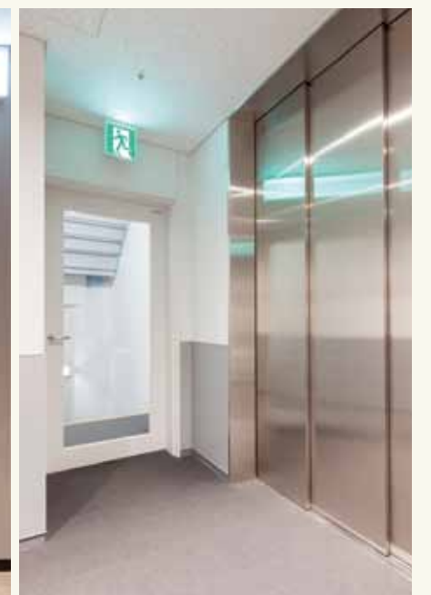
JR新宿ミライナタワーの5~32階はオフィス。スリット窓付きの防火ドアは、出会いがしらの衝突事故を回避するのはもちろん、ドアにアクセントが生まれるため意匠にも寄与します。
