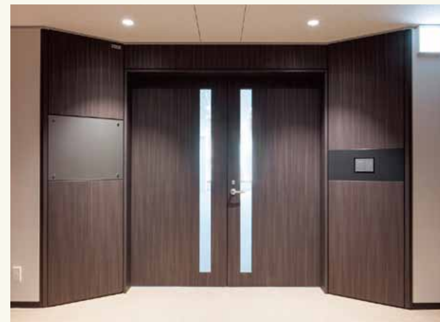
JR新宿ミライナタワーの5~32階はオフィス。スリット窓付きの防火ドアは、出会いがしらの衝突事故を回避するのはもちろん、ドアにアクセントが生まれるため意匠にも寄与します。
