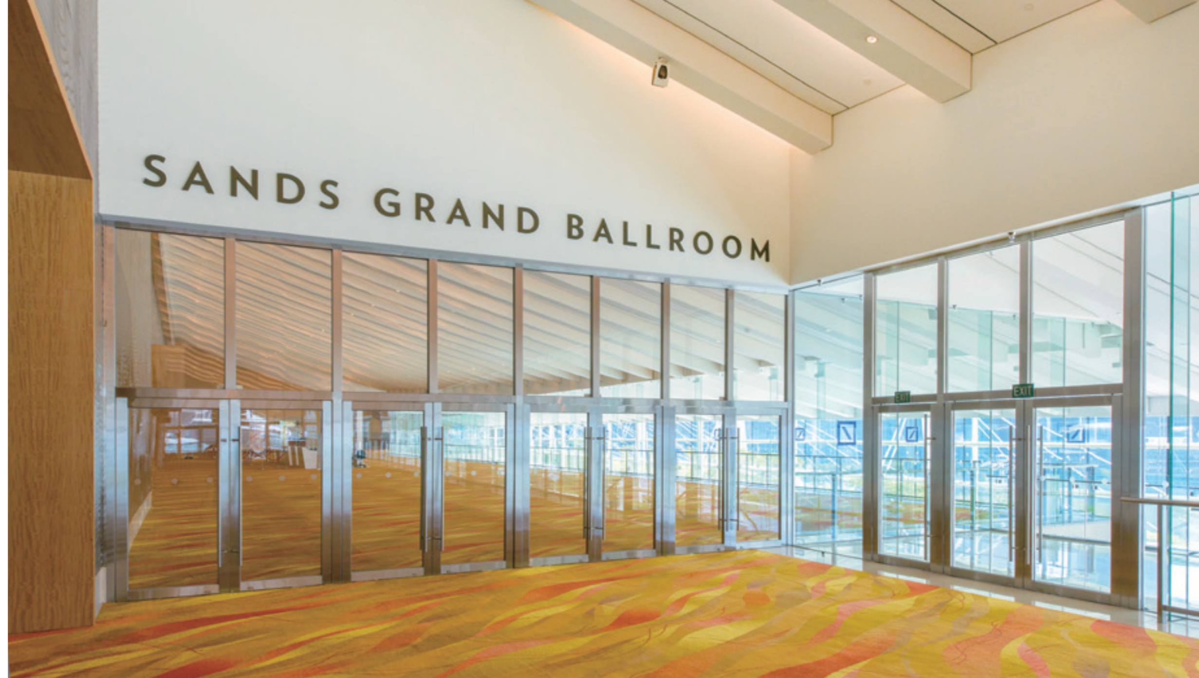
東南アジア随一の規模を誇るサンズ・グランド・ボールルームの出入口に採用されたファイアライト®。
