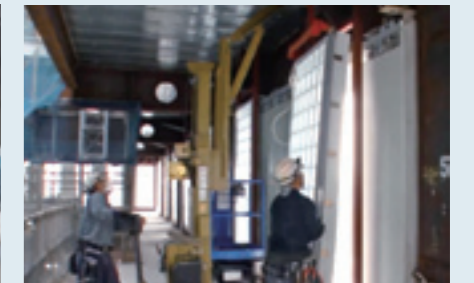
ユニット吊り込み
