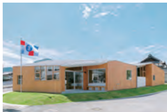
Good Job! Center KASHIBA 北棟(奈良県)
