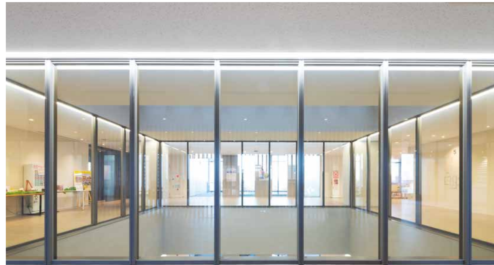
食堂の香りが漏れないよう、吹き抜けの周りにファイヤードS (三和シャッター工業製) が使用されている。
