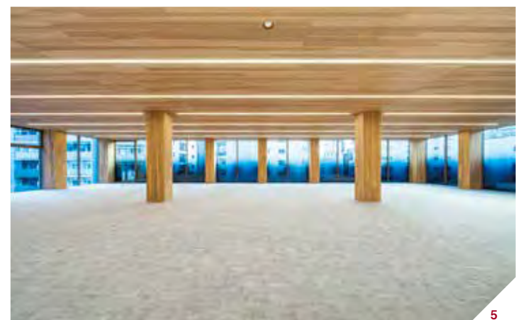
1・2・3・4 / 天井全面に、CLTを型枠兼たわみ補強として使用している。椅子や机などの家具には、紙管を使用。吹き抜け部に光が差し込む様子は、まるで森の中にいるような解放感 5 / 日当たりによる館内温度の上昇を防ぐため、色が変わる自動調整ガラスを採用している。
