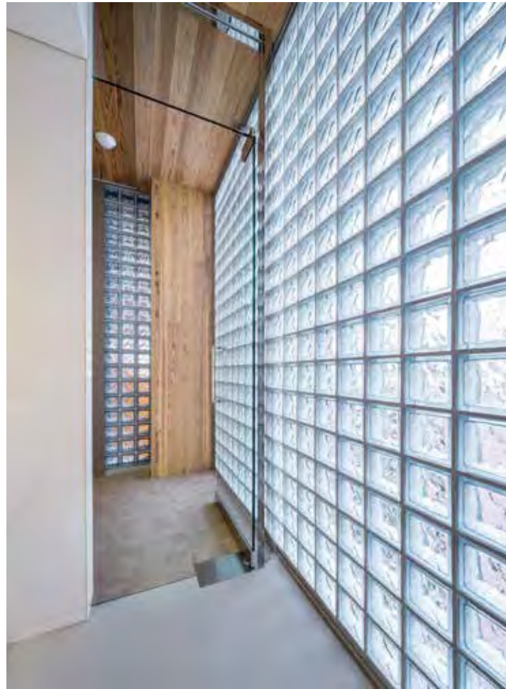
北西部外側の螺旋階段(屋外避難階段)の耐火仕様(二重積み)になることが決め手となった。
