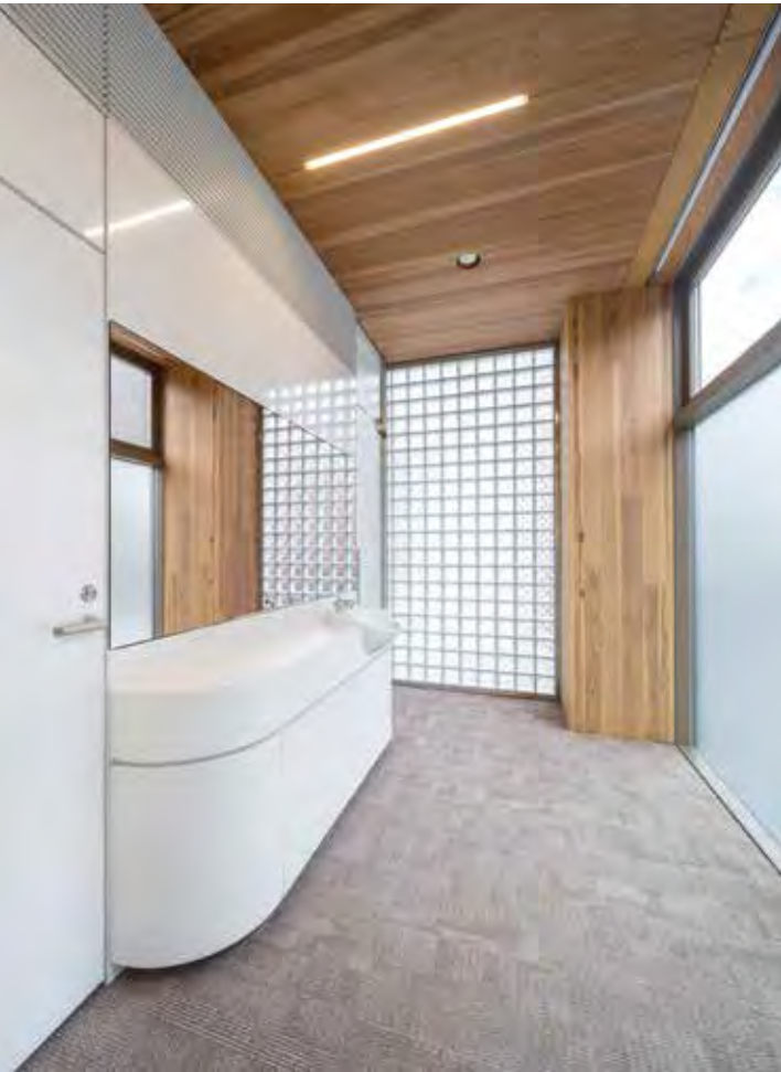
トイレや水回りがある北面にガラスブロックを採用。デザイン性が高く目隠しができて採光性がある。
