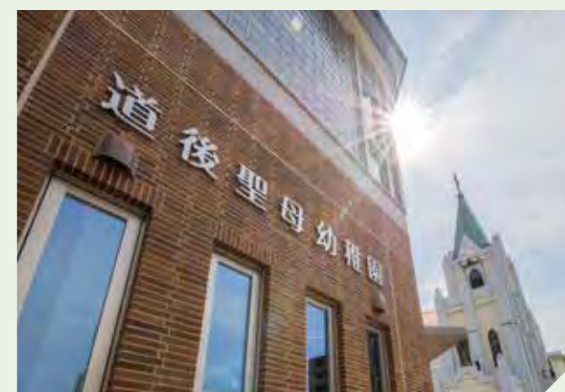
1 / 南側は平屋の園舎、北側が園庭。敷地の北東に八角形の遊戯棟が建つ。夜に室内の灯りを灯すと、神秘的な光景に。2 / 隣に立つカトリック教会とイメージを合わせて設計されている。
