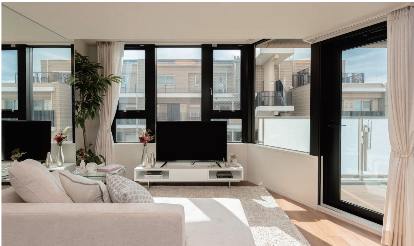
建物名称／パークホームズ甲子園四番町(兵庫) 施主／三井不動産レジデンシャル 設計・施工／村中建設 ※FIX窓がファイアライト入り防火設備です。
