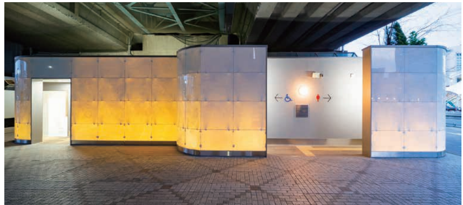
海浜幕張駅前広場公衆トイレ(千葉) 設計：千葉土屋建築研究所 撮影：大丸剛史
