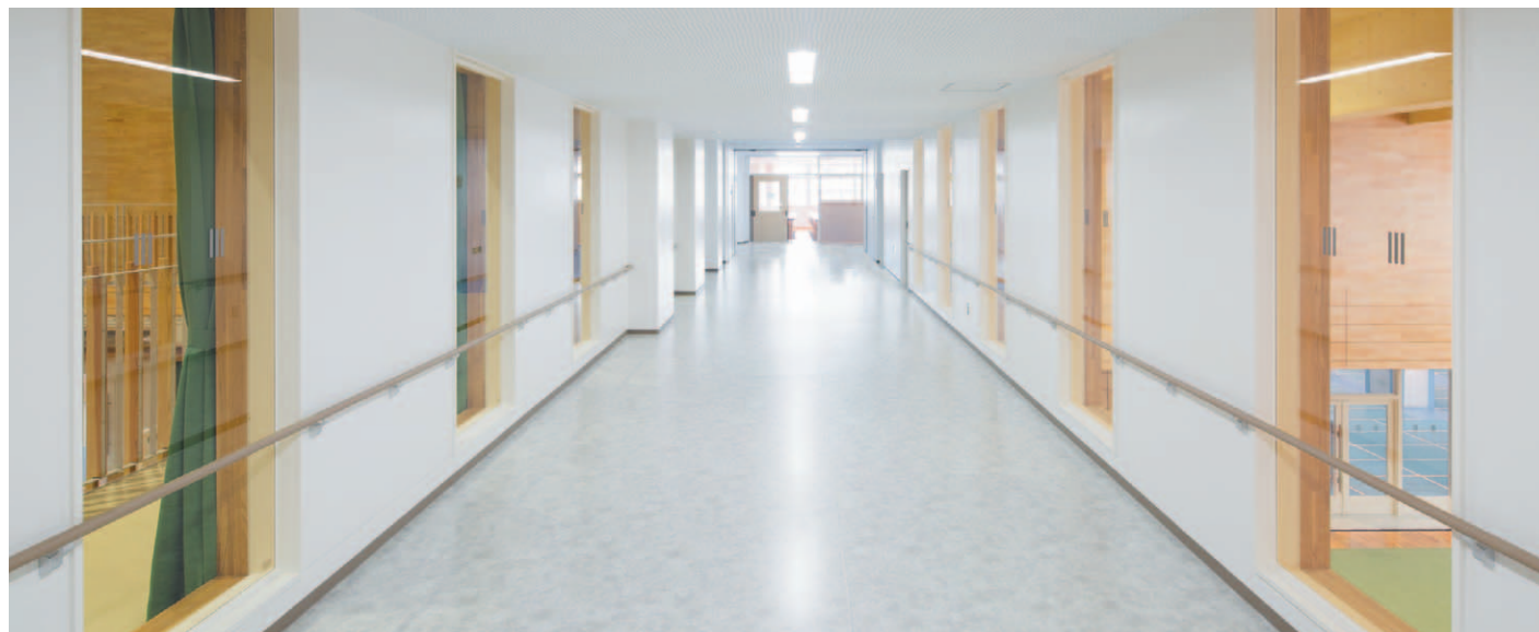
建物名称／足立区立鹿浜菜の花中学校 所在地／東京都足立区 設計／都市環境設計 施工／似鳥・武家田・小倉建設JV 撮影／大丸剛史
