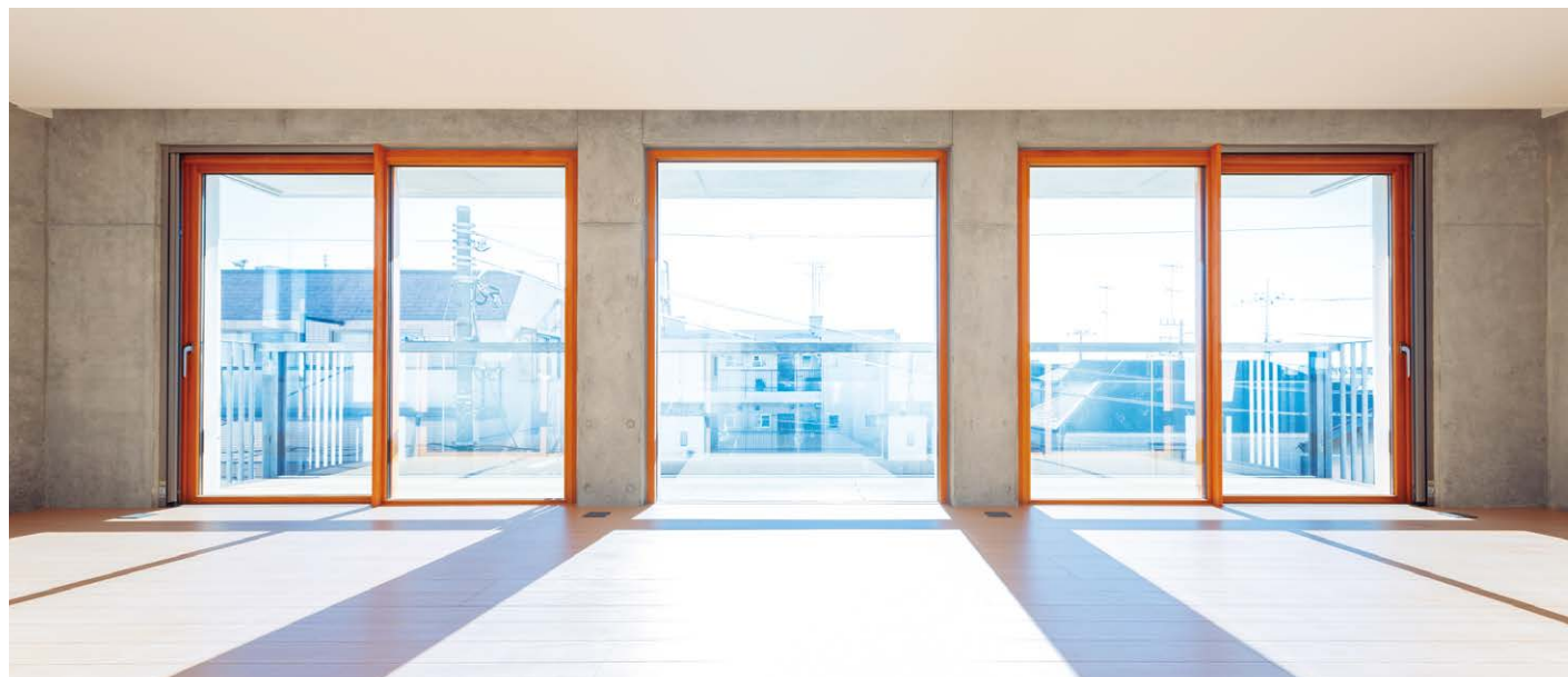
建物名称/雪月花(東京) 設計・施工/O-WORKS 撮影/大丸剛史 ※両サイドの引違い窓がファイアライト入り防火設備です。
