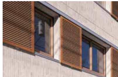
防犯性や日射遮蔽を考慮して、外壁には木製の雨戸をデザイン。木の耐久性を高めるために高温熱処理した木材を使用している。
