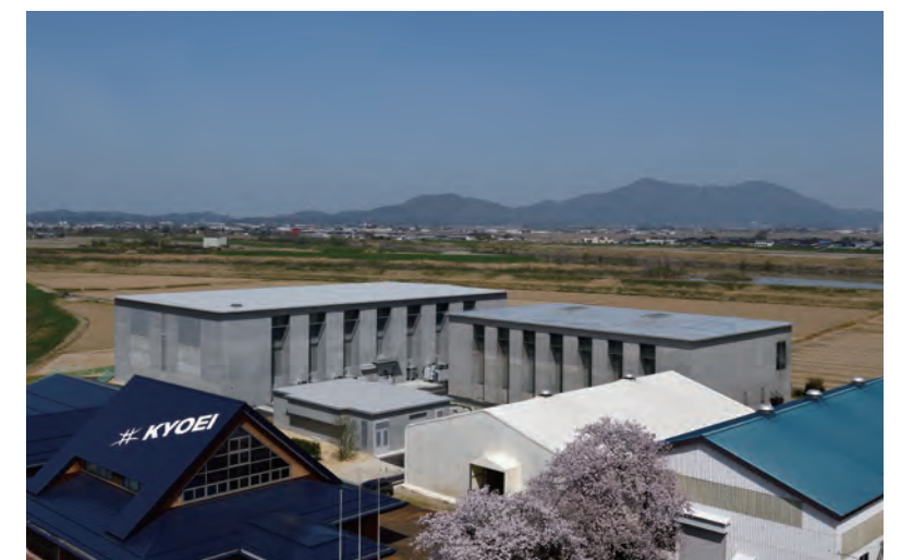
周囲を田畑に囲まれ、住宅が点在する静かな環境のなかに工場が建つ。近隣に騒音の影響を与えることなく夜間操業も行う。
