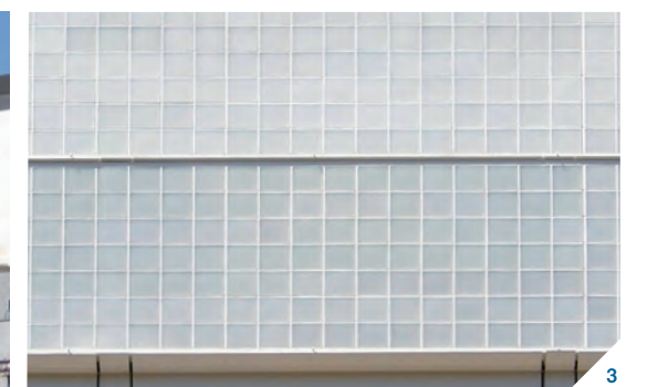
1/ 屋上プールの目隠しには乳白色のガラスブロックを使用。児童・生徒目線の高さで視界を優しく遮る。2/ 南東側外観。土佐堀川に面して7階建ての校舎が建つ。3/ 和紙のような温かい印象のガラスブロック オバリーンが校舎のアクセントになっている。
