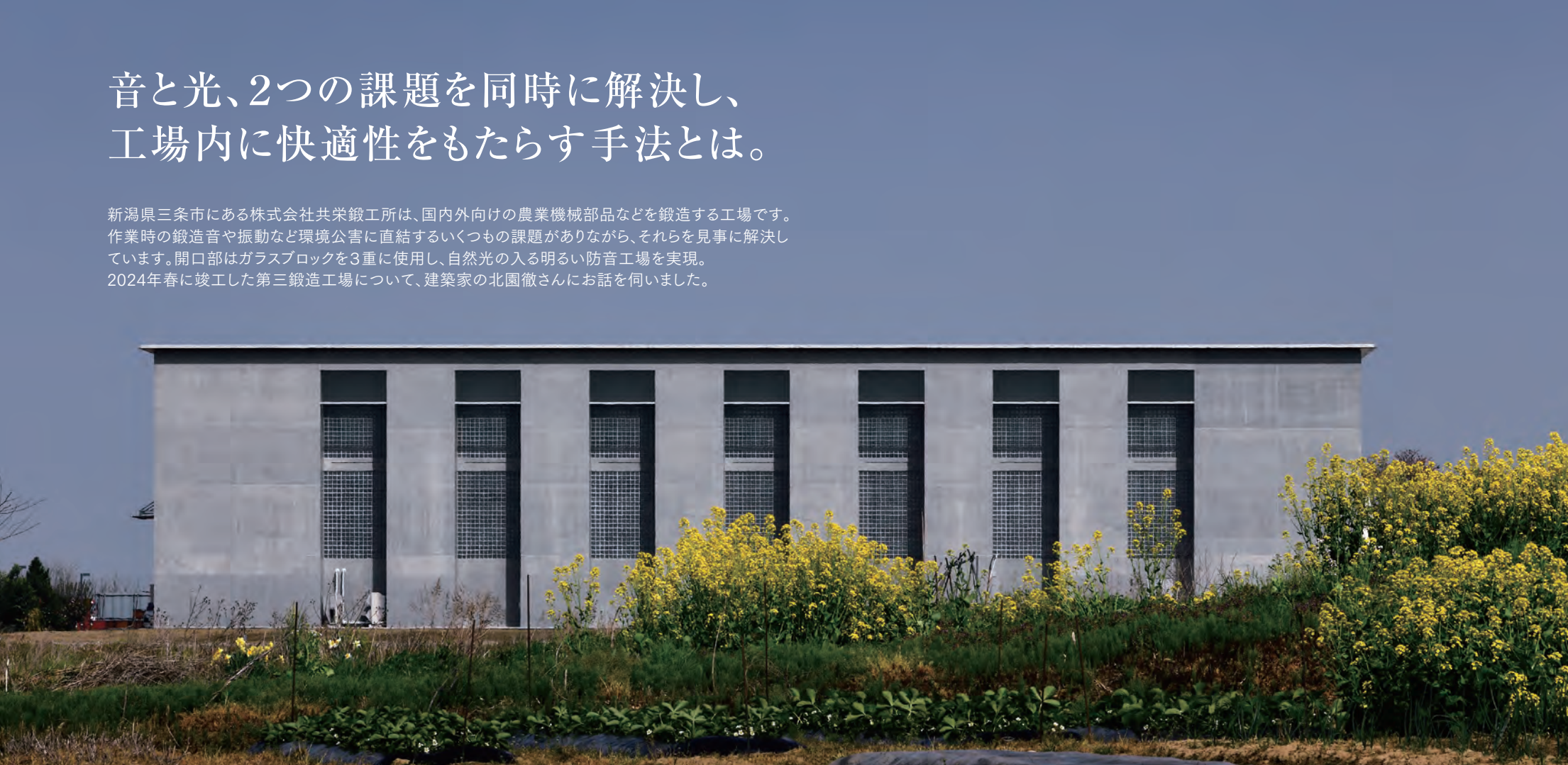
丹精な外観。室内に自然光を採り入れるガラスブロックの開口が連なる。
