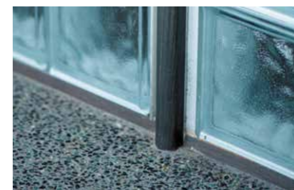
半円状の見切り材がガラスブロック壁のアクセントとなっている。
