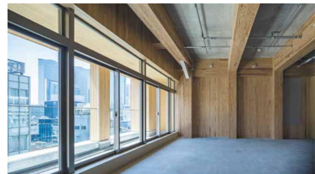
躯体の見える仕上げ前。木の構造体と内装の木質素材が同質で連続している。
