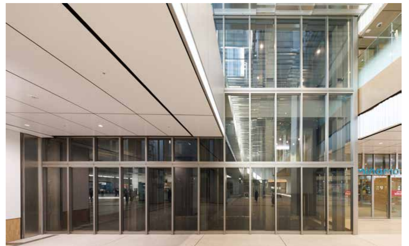
耐熱合わせガラスによるシースルーエレベーター。ガラスが建物のファサードに美しい連続性をもたらす。
