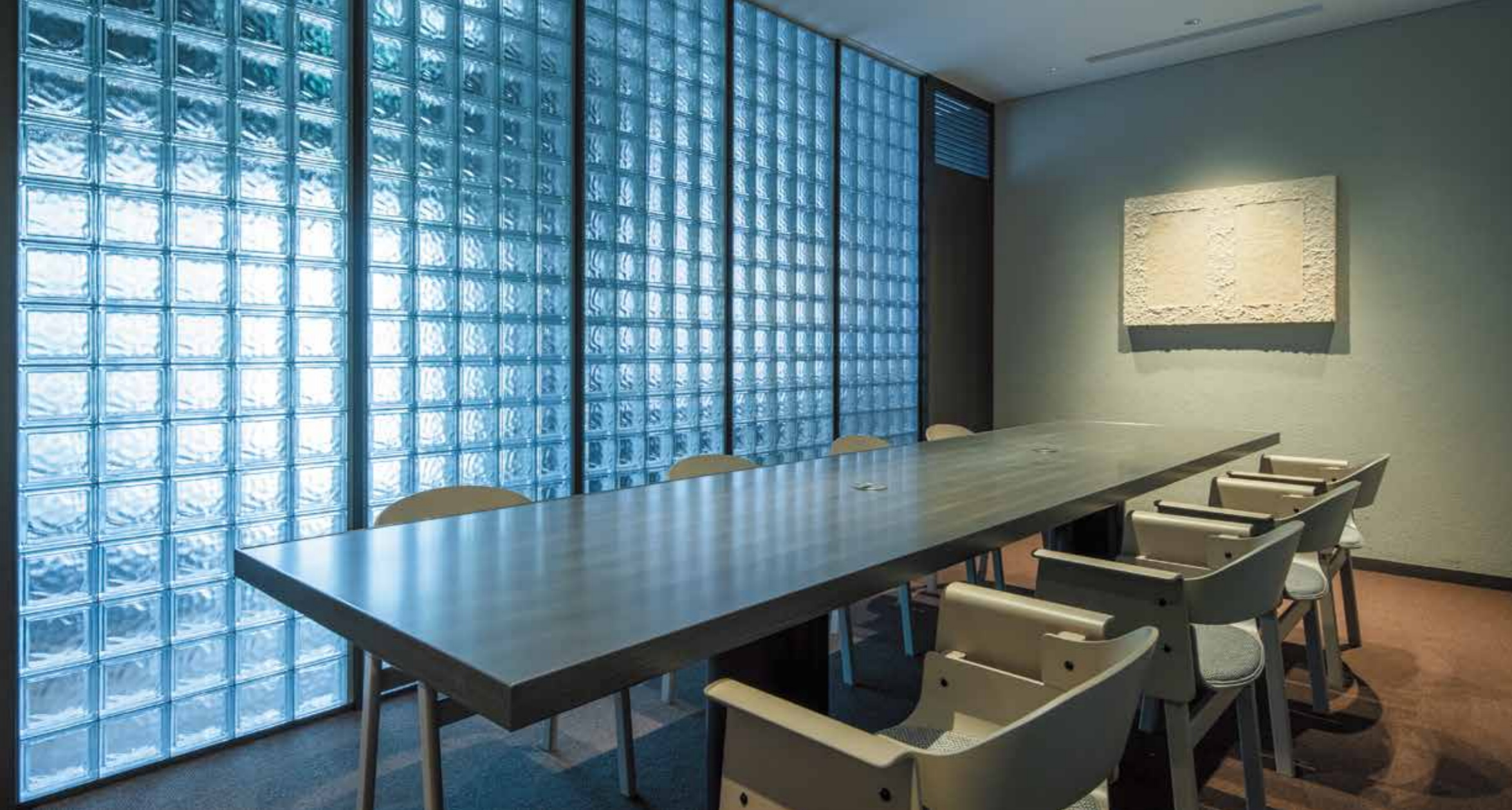
アルミプレートを用いるメタルジョイント工法で目地を極めて細く。 ガラスブロックのみで端正に積層しているように見える。
