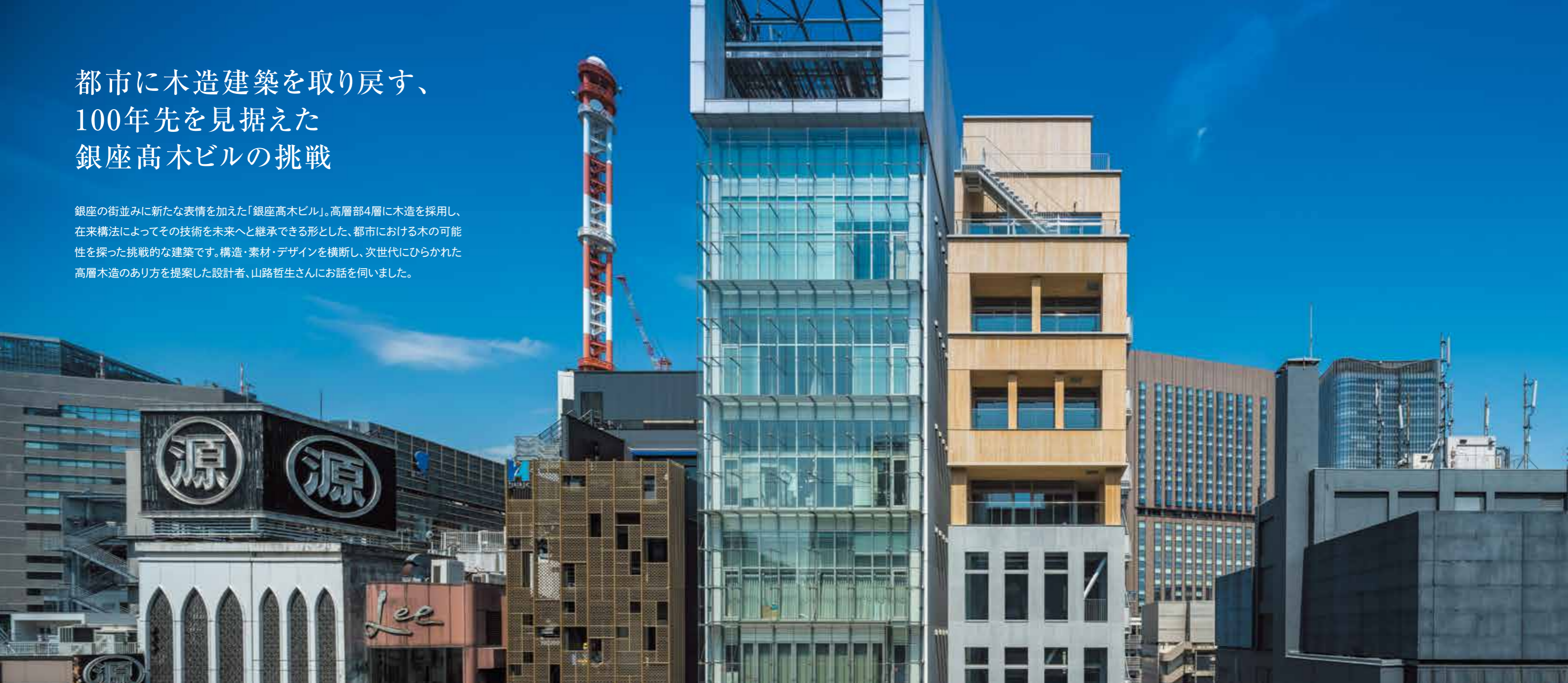
ビルの上層4階は木造。8階建てのオフィスビルの上に積まれた木の箱は、ビル群の中で浮遊しているように見える。
