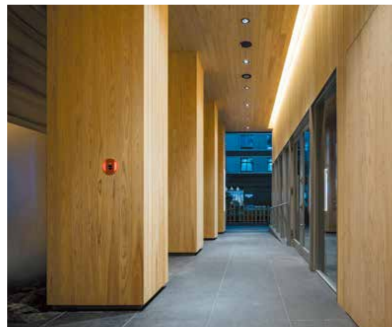
1階アプローチ。鉄骨の柱や天井の仕上げも木質素材で揃える。
