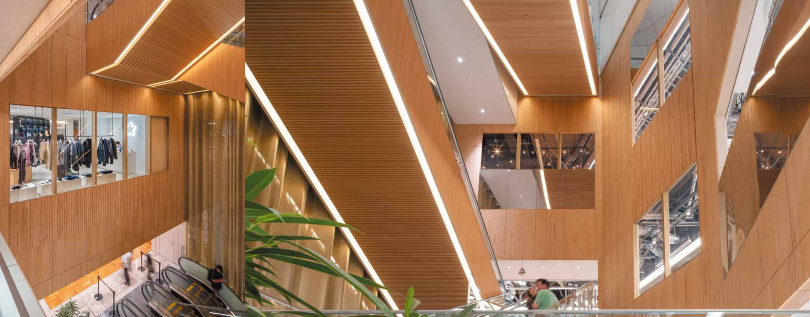
エスカレーター空間の大胆な吹抜け。木質調の仕上げが上階まで連続し、クリアな耐熱合わせガラスを使用した大きな開口部が各階ごとの風景を伝える。
