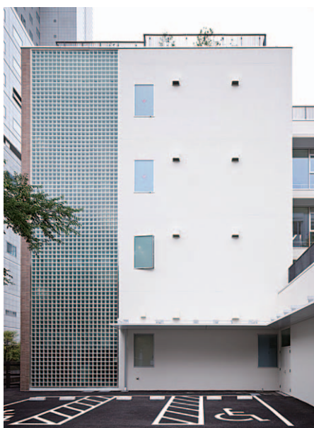
千代田区立麹町中学校（ガラスブロック面にSG防汚ガラスコートを塗布）
