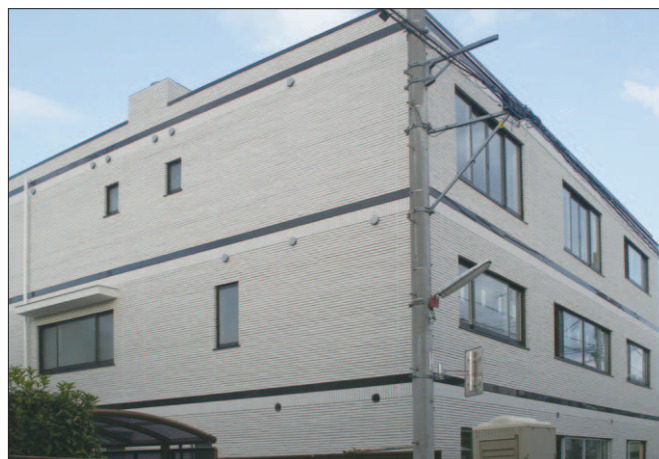
片桐邸〔ボーダータイル下地〕
