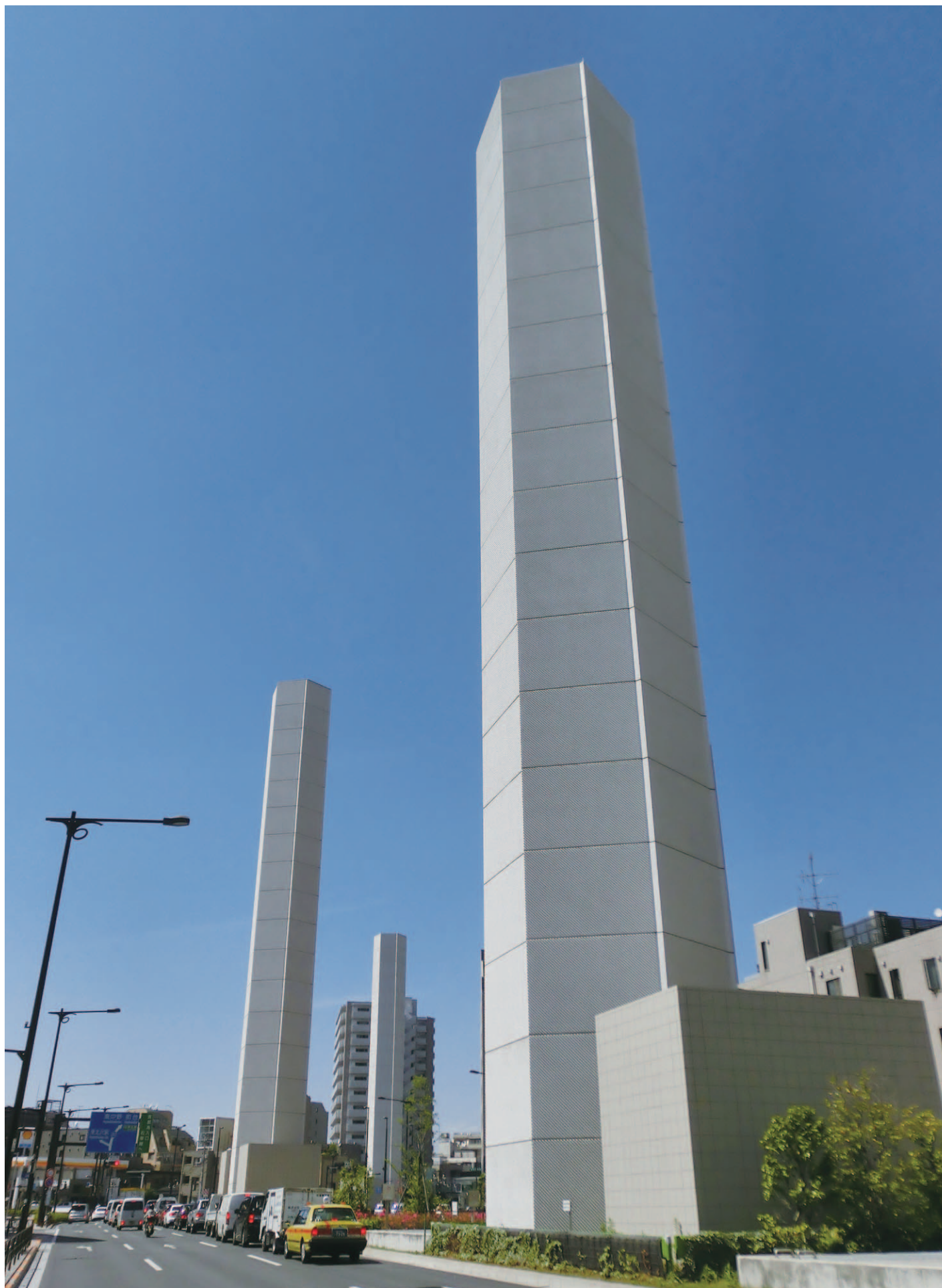
首都高速中央環状新宿線トンネル神山町換気所（排気塔：PC板面にSGコート色付きを塗布 給気塔：タイル面にSGコート外装用を塗布）
