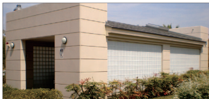
浦安市日の出おひさま公園公衆トイレ（RC左官、ガラスブロック面）
