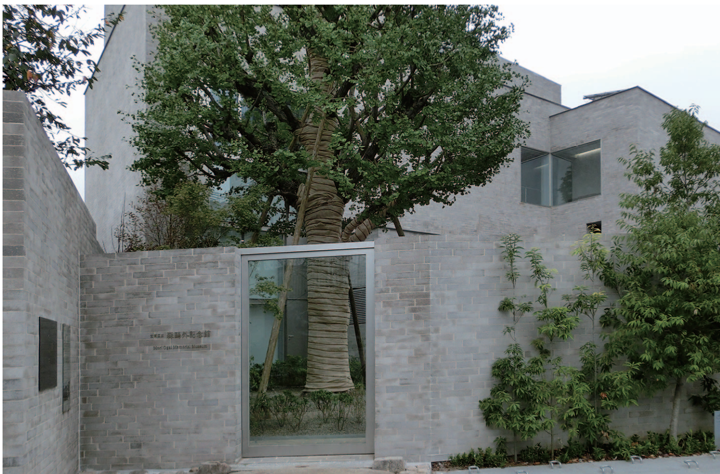
文京区立森鴎外記念館（削りタイル面にSGコート外装用、コンクリート面にSGコート打ち放し用を塗布）
