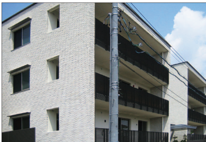
浜松エスペランサー〔タイル下地〕
