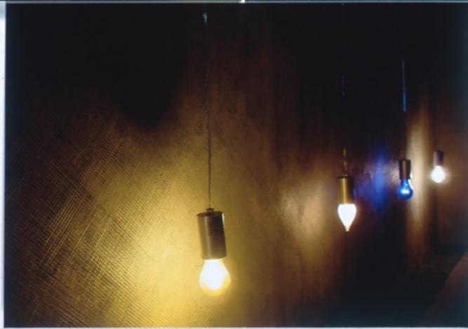
コメント 店舗は大阪市・平野町に位置し、寝屋橋WESTプロジェクトの先駆けとして完成、奥のフロアへとむすぶ廊下の壁面に付して、1000×1000シートサイズのスーパークリップコン・ネットを重ね貼りのうえ、グレー塗装にて仕上げる。製品本来の用途とは異なる使用だが、ネット状のガラス繊維を表皿へ展開させた事例。
