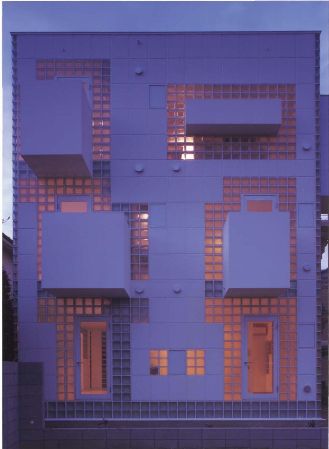
「クリスタルブリック('04)」では、鉄骨造とガラスブロック造を日本電気硝子と共に開発した。前回までの垂直荷重を受けるフラットバーと耐震壁としてのGBの構成に加え、今回は賃貸棟としての要素から、コスト削減を図る為、GBと同等の圧縮強度であるALCを選択し、実験を行った。それにより、鉄骨造+GB造+ALC造による新たな構造を可能とした。外部に見えているものはサッシュ以外が全て構造体になっている。
