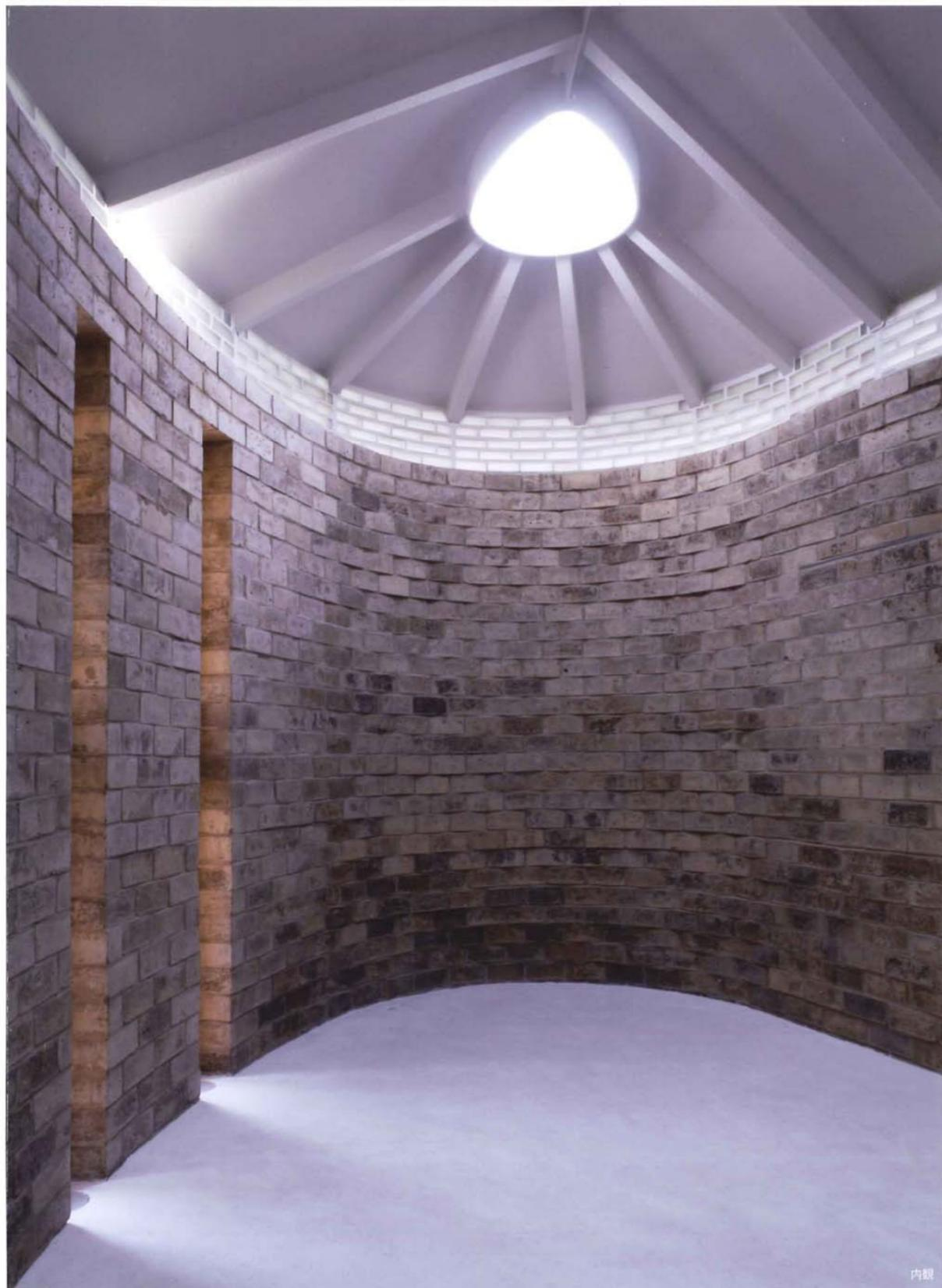
コメント 建築素材として“土”の可能性を見つめ直し、“土を構造体”とする構法を開発することを目的として様々な研究と実験を繰り返し、土に自然添加物のみを混入して強度を満たした土ブロックを開発しました。この建物は、全て手作業で作られた約2500個の土ブロックのみを積み上げた、組積造の壁が構造体となっています。
