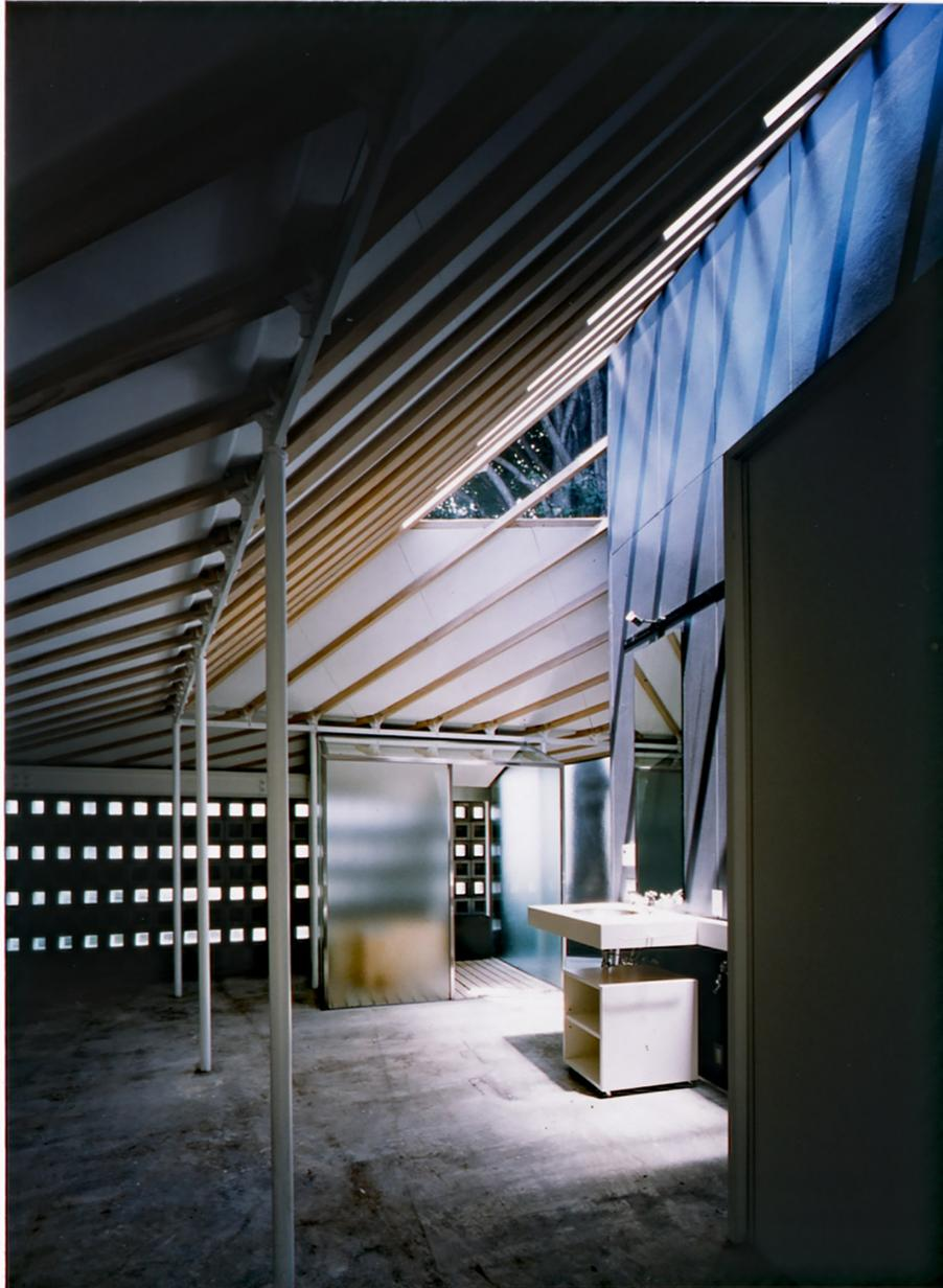
ガラスブロックのあっけないほど簡単な使い方の提案。既成の穴開きコンクリートブロック（200角）に、半透明のガラスブロック（カスミ115角）をはめ込んで、住宅の壁を作ってしまうというもの。スポンとはめるのにちょうど良いサイズだった。敷地北側の水路敷に面し、延焼ラインにもかかるので、まさにガラスブロックが持って来いであった。外壁と塀の役割を同時に果たしている。ガラスを通して入ってくる自然光が鈍重なブロックの印象を和らげ、光を取り入れつつ視線を遮断する「半透明な」壁（塀）を作り上げた。この部分の内側の機能は主として納戸やフロ、トイレ、洗面など、日本の昔の家ではみな母屋からやや外れて置かれたたものである。
