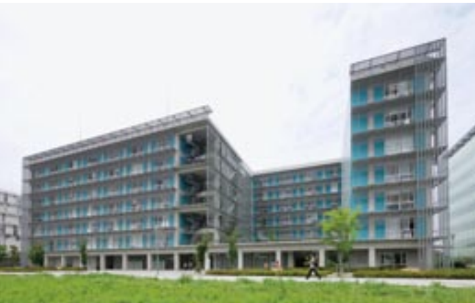
環境棟南側外観。断熱材入り外装パネルと庇とルーバーの組み合わせで熱負荷を軽減する。
