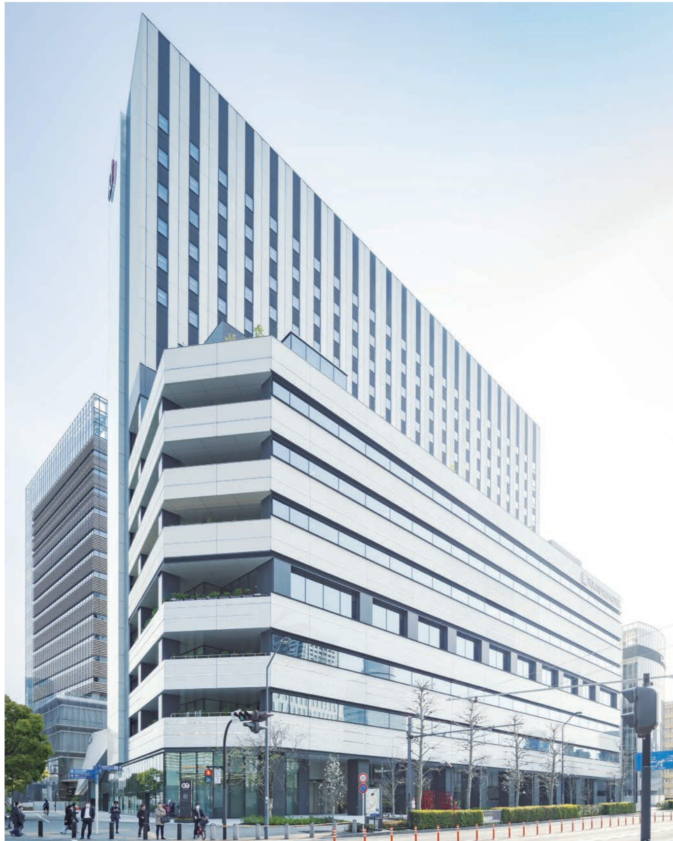
結晶化ガラスであるネオパリエ®は、吸水率ゼロで汚れに強い。また、自然石にはない均一な白さを実現できる。
